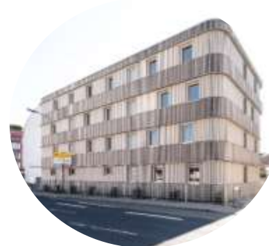
Sinsheim 1 Haus 11 Wohnungen
